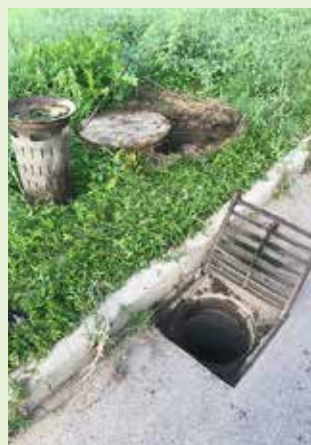
Čištění vsakovacího systému dešťových vod v ulici Františka Nepila
