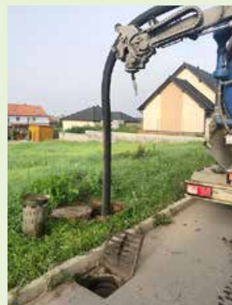
Čištění vsakovacího systému dešťových vod v ulici Františka Nepila
