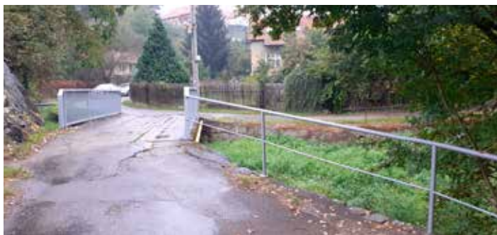
Most Libinská - nové zábradlí z důvodu bezpečnostních norem
