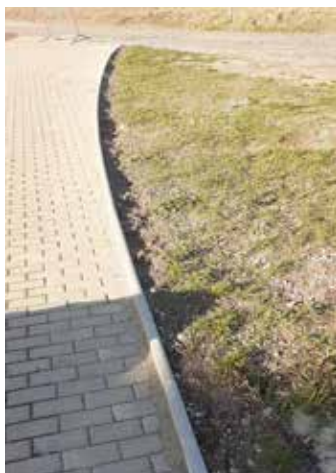
Oprava poničených obrubníků
